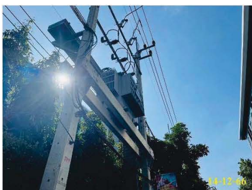
หม้อแปลงไฟฟ้า ขนาด 800 KVA พร้อมตู้ควบคุมไฟฟ้าอาคาร B
